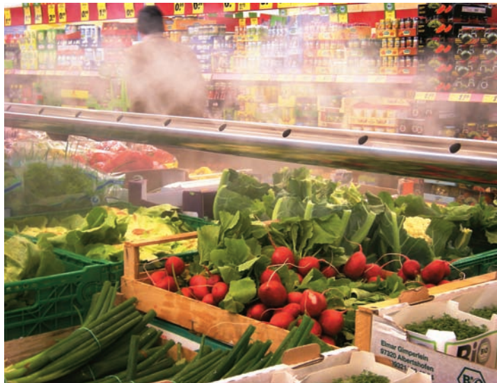
Un caso di grande evidenza del processo di valorizzazione della formula: nel reparto ortofrutta una struttura di umidificazione favorisce la shelf life del prodotto
